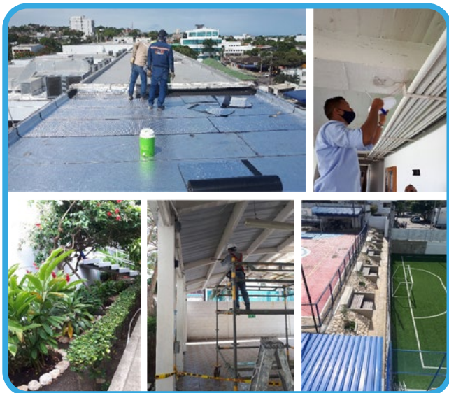
Ilustración 69. Actividades de Mantenimiento de infraestructura
